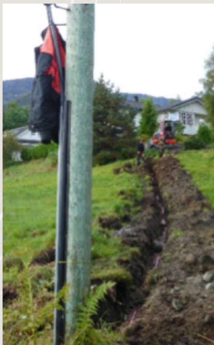
Fibergrøft i arbeid.
